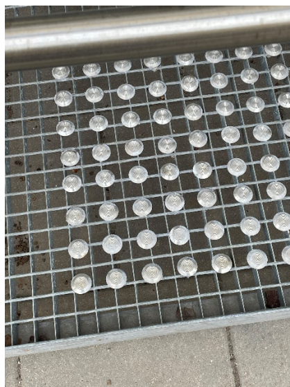
7 pav. Taktilinių paviršių tvirtinimas prie plieninių grotelių
